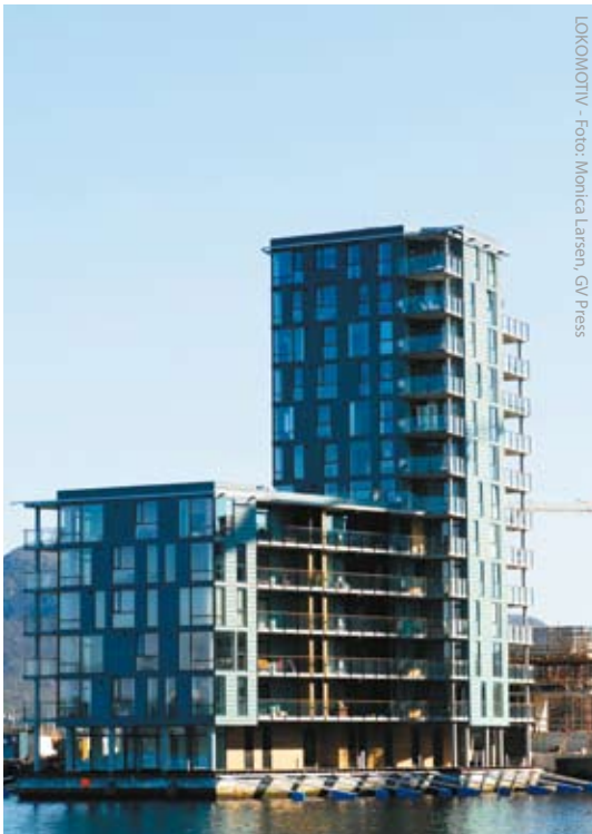
Høy standard. Utbygging av området Hinna Park omfatter en rekke leilighets- og næringsbygg hvor Kruse Smith har ansvar for brannsikringen. Som her i Hinna Brygge.
