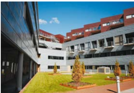
Stort omfang. Elvegaten 11 på Sandnes har 105 leiligheter og fire etasjer med næringsvirksomhet. Brannsikringsarbeidet har tatt to år.
