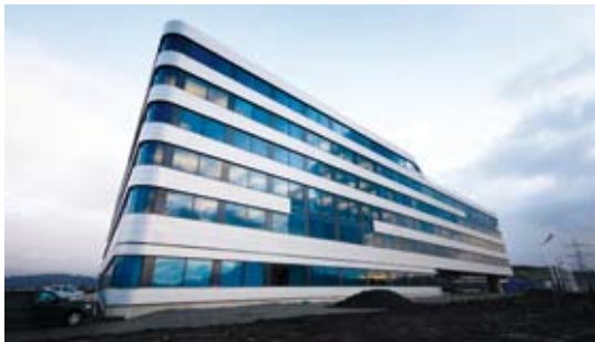
Strengt krav. Vetco Aibels kontorbygg på Forus er forskriftsmessig brannsikret og dokumentert.
