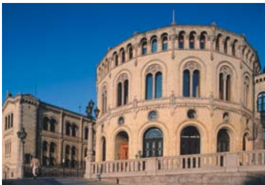
Store ting. Ved ombyggingen av Stortinget i 2006 var det brannsikringsentreprenørene i Kruse Smith som hadde ansvar for at brannskillevegger og dekker ble forskriftsmessig brannsikret.
